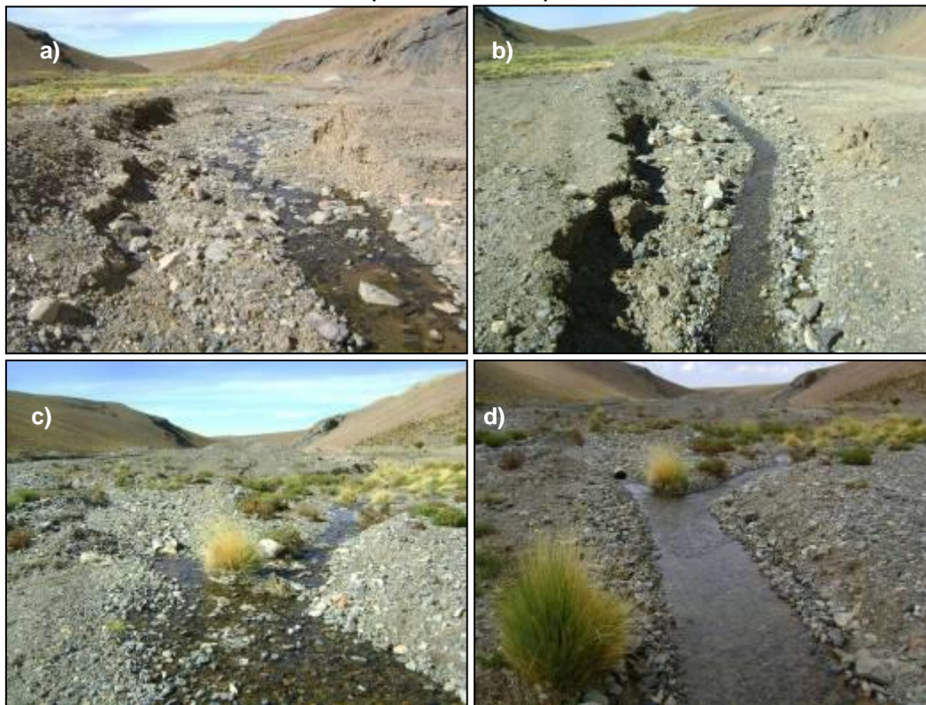
Fotografías 22. a) y c). Canal evacuación escurrimientos quebrada Chiclla antes de mantención; b) y d) Canal evacuación escurrimientos quebrada Chiclla después de mantención.
