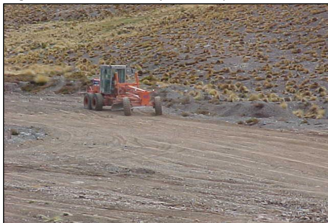
Fotografía 11. Motoniveladora mejorando la superficie de las terrazas.
