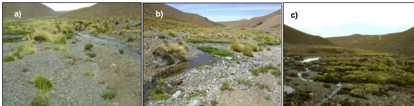
Fotografía 18. a), b) y c) Canal evacuación aguas lluvias colmatado
